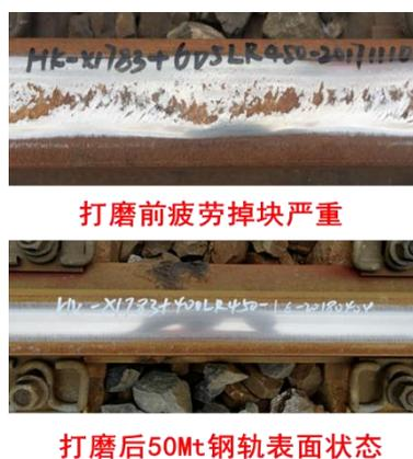
图 3：钢轨打磨前后状态对比图
